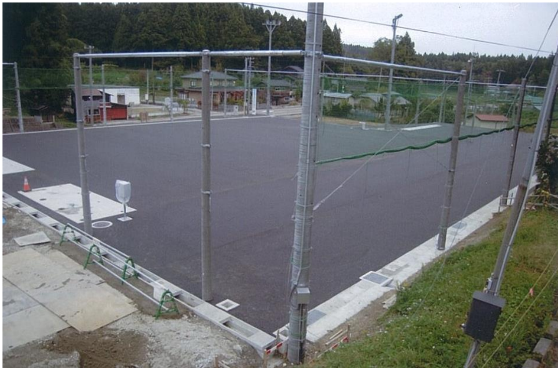
舗装工事 完了
