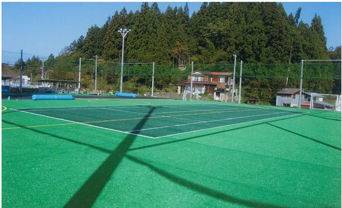
人工芝敷設 完了
