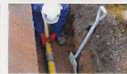
水路のパイプライン化
