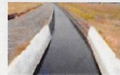
水路の長寿命化
