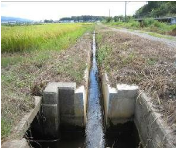
かんがい排水事業「排水路の新設」
