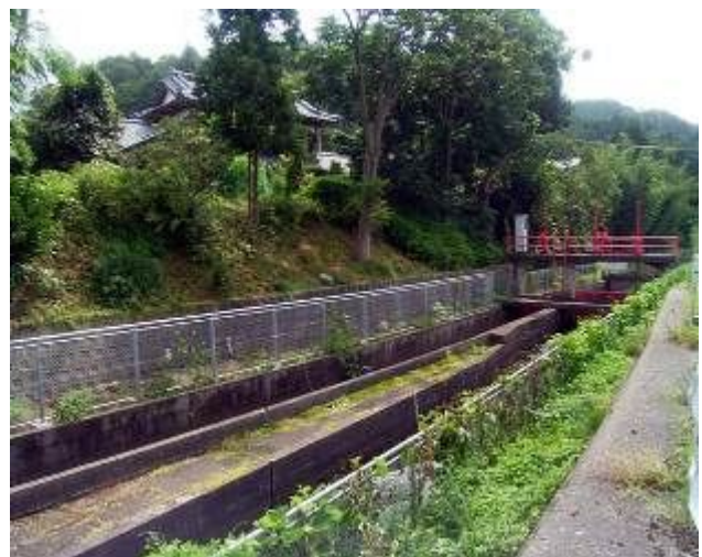
アメニティー施設整備事業「転落防護柵の設置」
